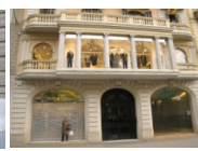
sobre nivel calle
