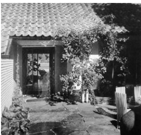
Villa Ervi, acceso y estado actual del vestíbulo
