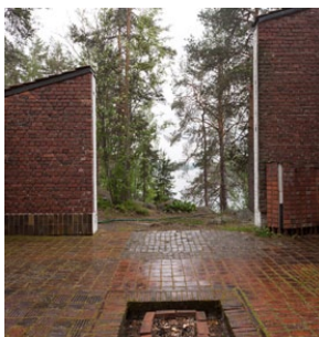
Alvar Aalto, Casa Experimental en Muuratsalo (1953)
