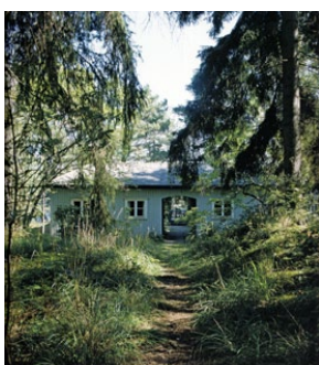
Alzado y fotografía del acceso a Villa Oivala
