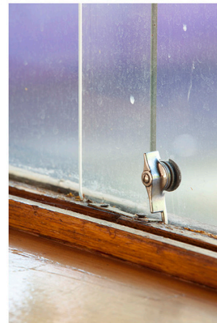
Casa Huarte: detalles de las carpinterías exteriores. Sistema Pearson de hoja corredera sin cerco. Fotografías: Miguel de Guzmán
