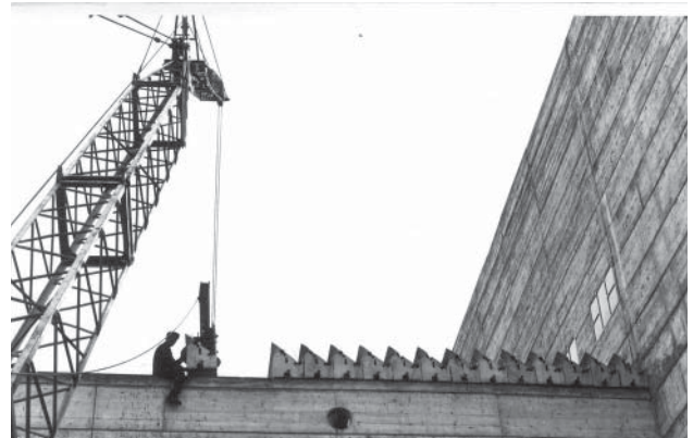
HUECOSA es el verdadero intento de industrializar los huesos . Diferentes imágenes del proceso de fabricación y montaje de vigas-hueso en Vic, Barcelona. En la imagen lateral Miguel Fisac comprobando los procesos de fabricación de las dovelas de HUECOSA. Archivo Arumí.
