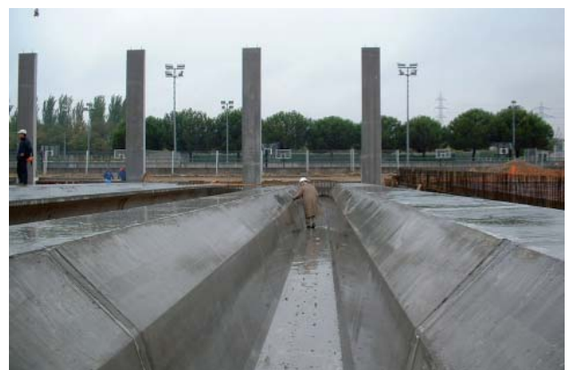
Imagen de Fisac paseando por el interior de la viga de Getafe (2002).
