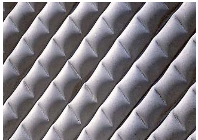
Patente a nombre de Miguel Fisac, 1973, "Sistema de encofrados flexibles para hormigón". Y su realización práctica en los paneles de cerramiento de Getafe. ALVISA.
