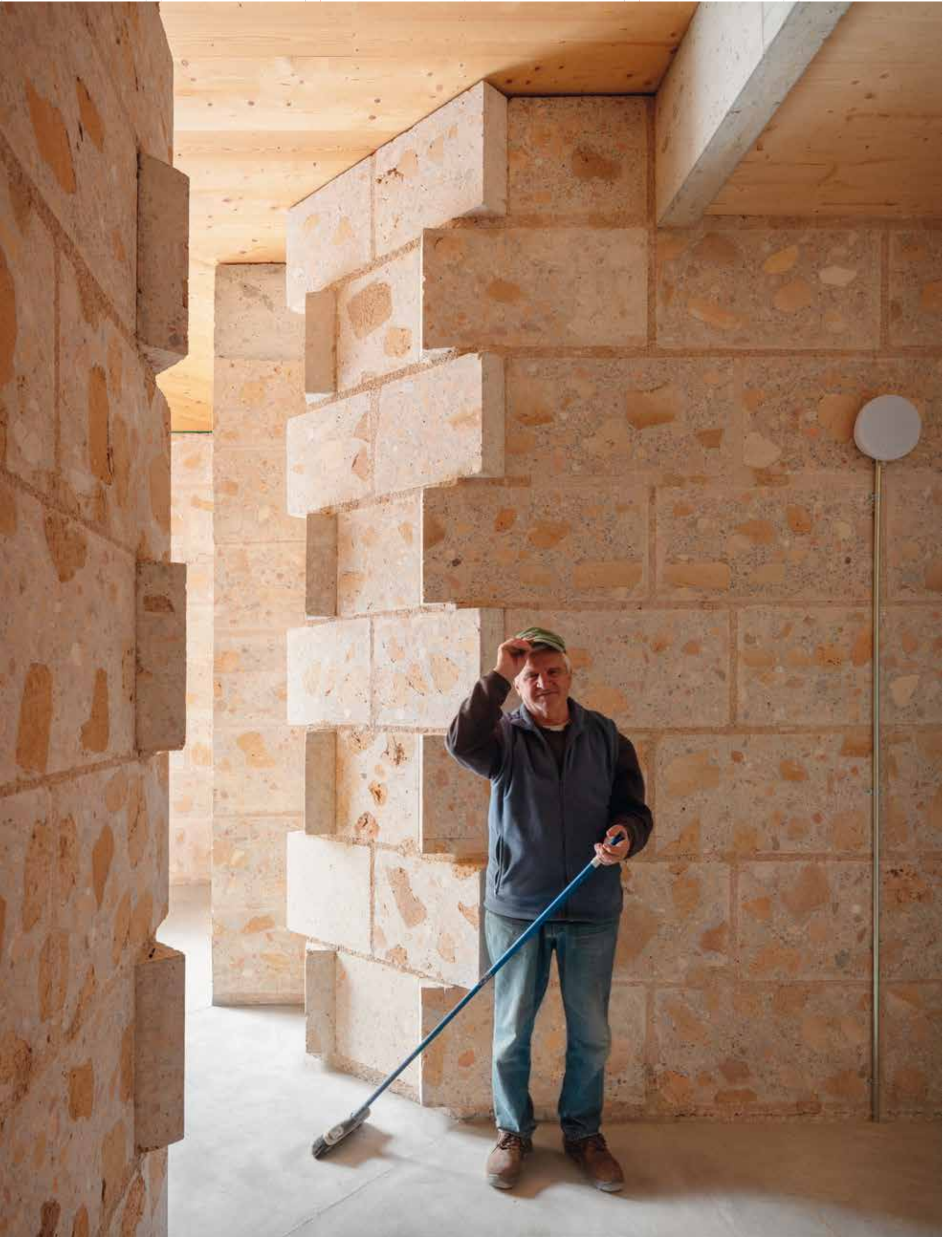
Giorghio y los bloques de minería urbana de piedra arenisca reciclada en 25 Alojamientos dotacionales para gente mayor en Palma. HARQUITECTES. Foto: Milena Villalba / Giorghio and the recycled sandstone urban mining blocks in the 25 temporary cohousing units for elderly people in Palma. HARQUITECTES. Photo: Milena Villalba
