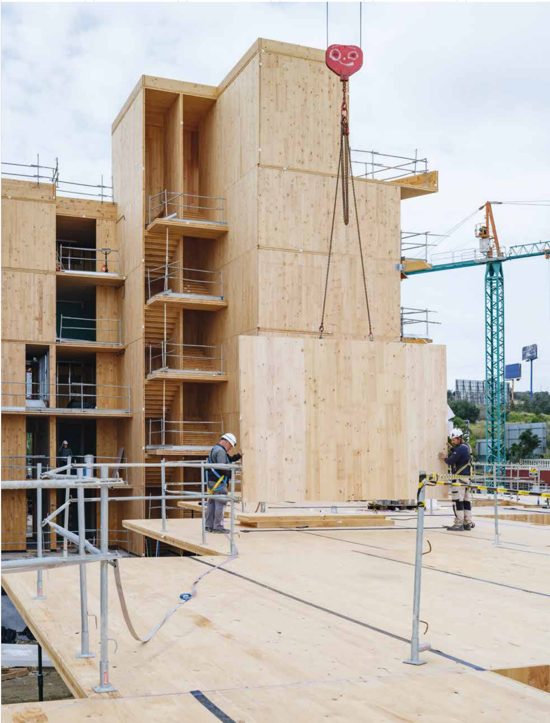
Edificio de apartamentos coliving Oceanika en Torremolinos (Málaga). En construcción. Bakpak architects. Foto: María Azkárte / Apartment building "coliving" Oceanika in Torremolinos (Málaga). Under construction. Bakpak architects. Photo: María Azkárte
