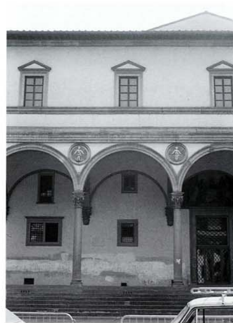
9.6 Detalle de la fachada del Hospital de los Inocentes.
