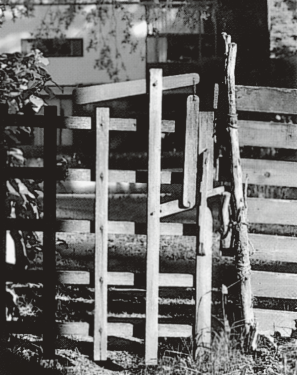
Alvar Aalto. Mecanismo de madera para el cierre de la verja en la Villa Mairea.
