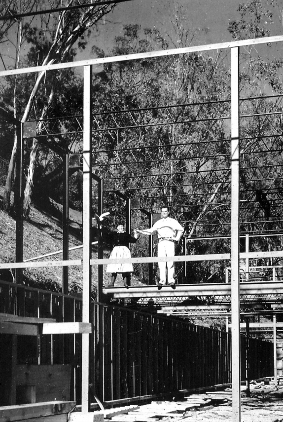
Charles Eames. Casa Eames, Pacific Palisades, 1947-1948. Charles y Ray durante la construcción.
