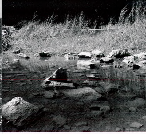
Restauración de la Pedrera dels Ocells
