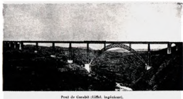
Pont de Garabit (Eiffel, ingénieur).
