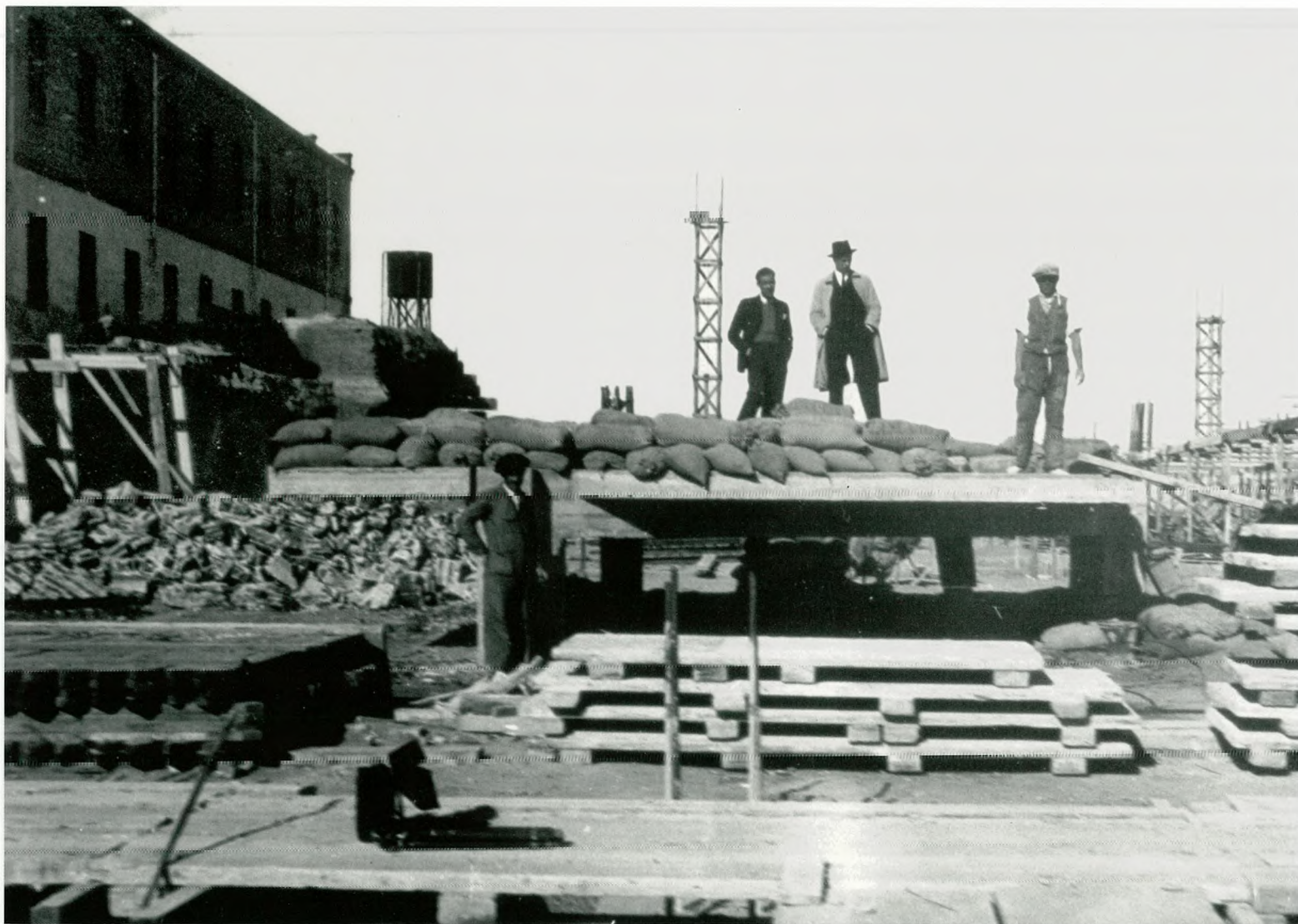
6. Prueba de carga del tramo de losa ensayado a escala real.
