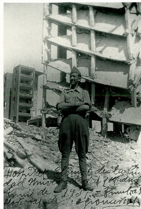
20. El Hospital Clínico destruido por las bombas.
