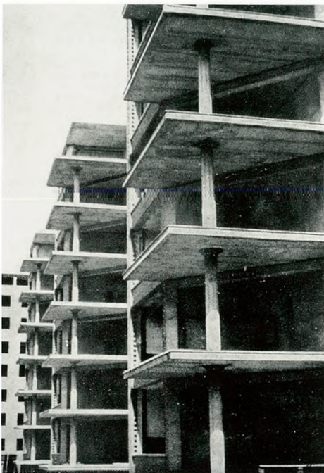
10. Estructuras de las placas del solario de los cuerpos en martillo del Hospital Clínico.
