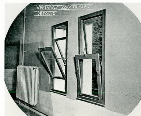
7. Ventanas de ventilación tipo Austral del Hospital Provincial de Toledo.
