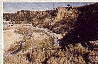
Gabions de protecció dels talusos.
