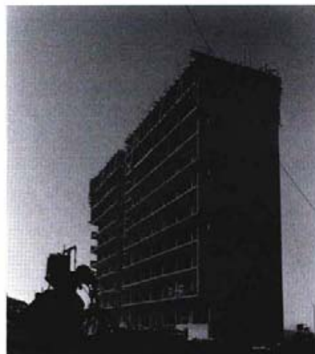
138 Imagen del bloque A en construcción.
