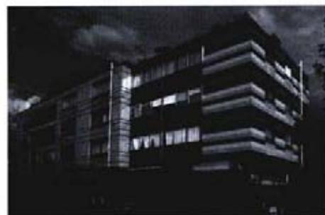
4 Viviendas en Neguri, grupo Ergoyen, 1966-1969.
