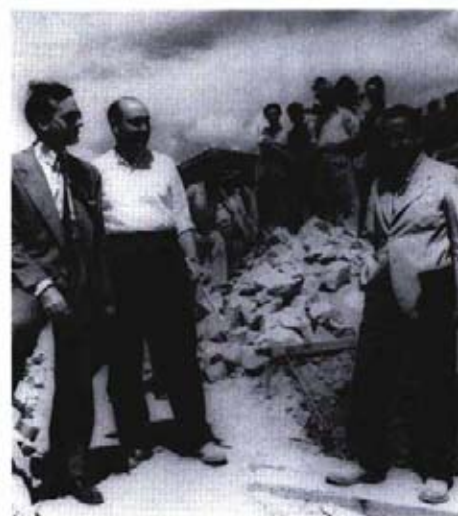
124 Rafael Aburto, con otros compañeros de la OSH, durante una visita de obra.
