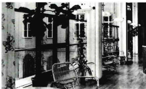
187. Galería de la planta principal de los Tribunales.
