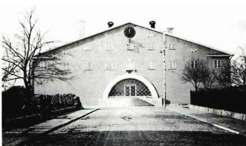
184. Fachada principal del Tribunal de Lister.
