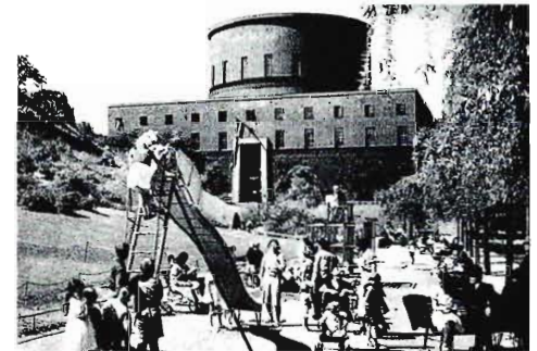
56. Fachada sur de la Biblioteca Municipal de Estocolmo, 1920-1928.
