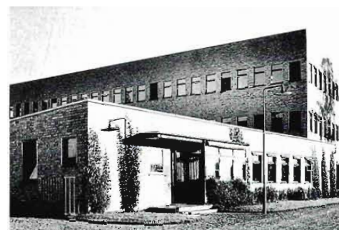
59. Laboratorios Bacteriológicos del Estado en Estocolmo, 1933-1937. Edificio principal.
