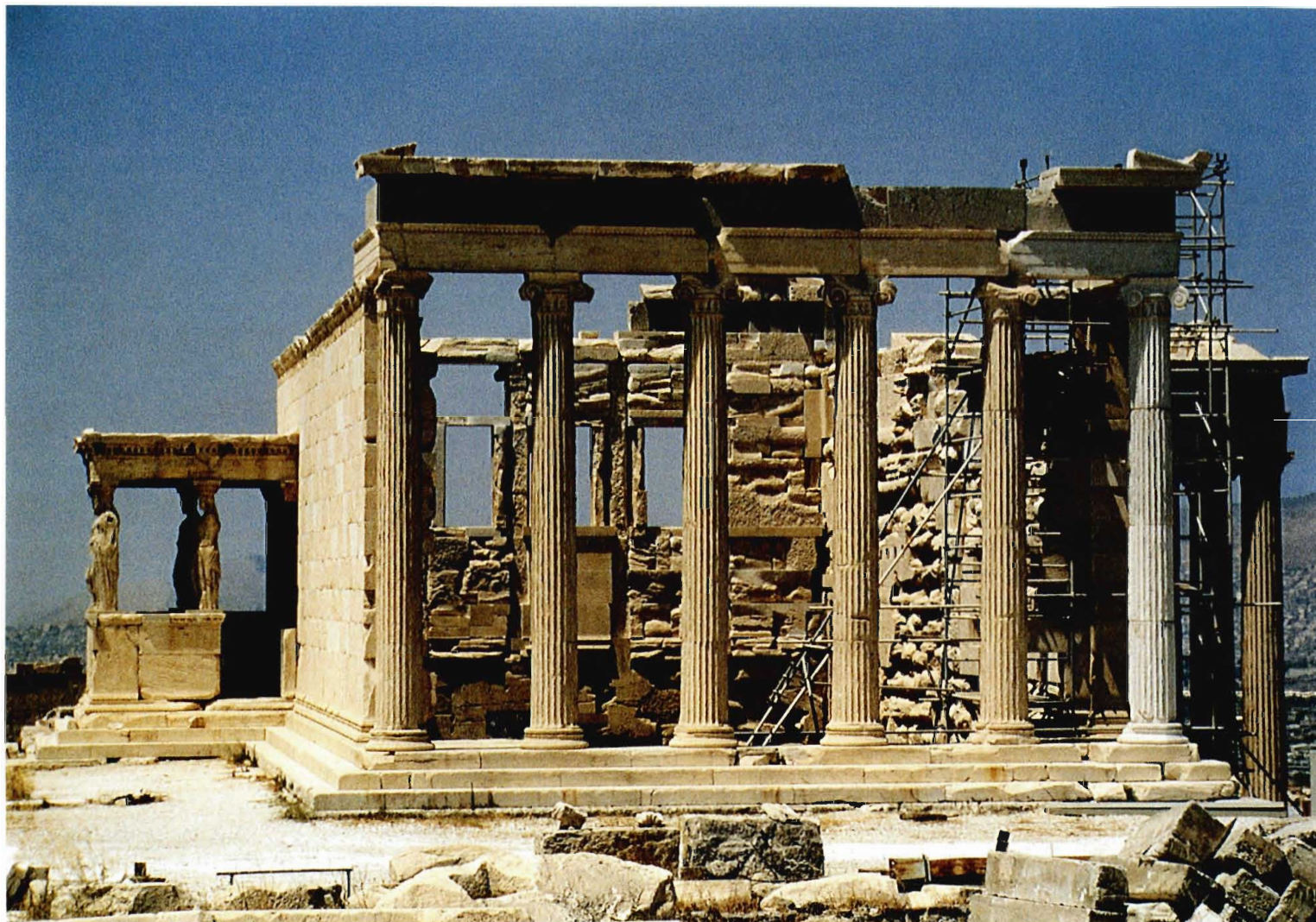
262. Los pórticos Norte y Este, el muro Sur y el pórtico de las Cariátides
