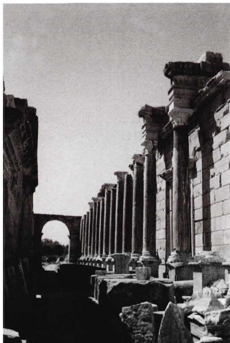
296. Calle en torno al Foro de Septimio Severo. Leptis Magna
