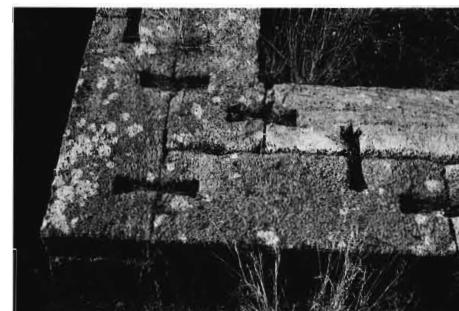
222. La precisión dórica: anclaje de muro en esquina. Olimpia
