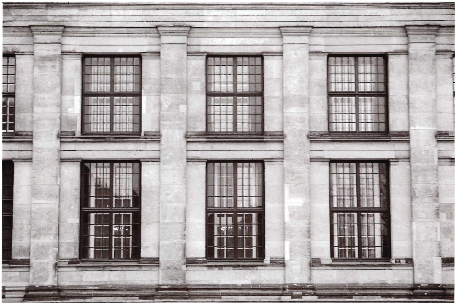
242. Muro schinkeliano. Lateral del Schauspielhaus. 1818-21. K.F. Schinkel
