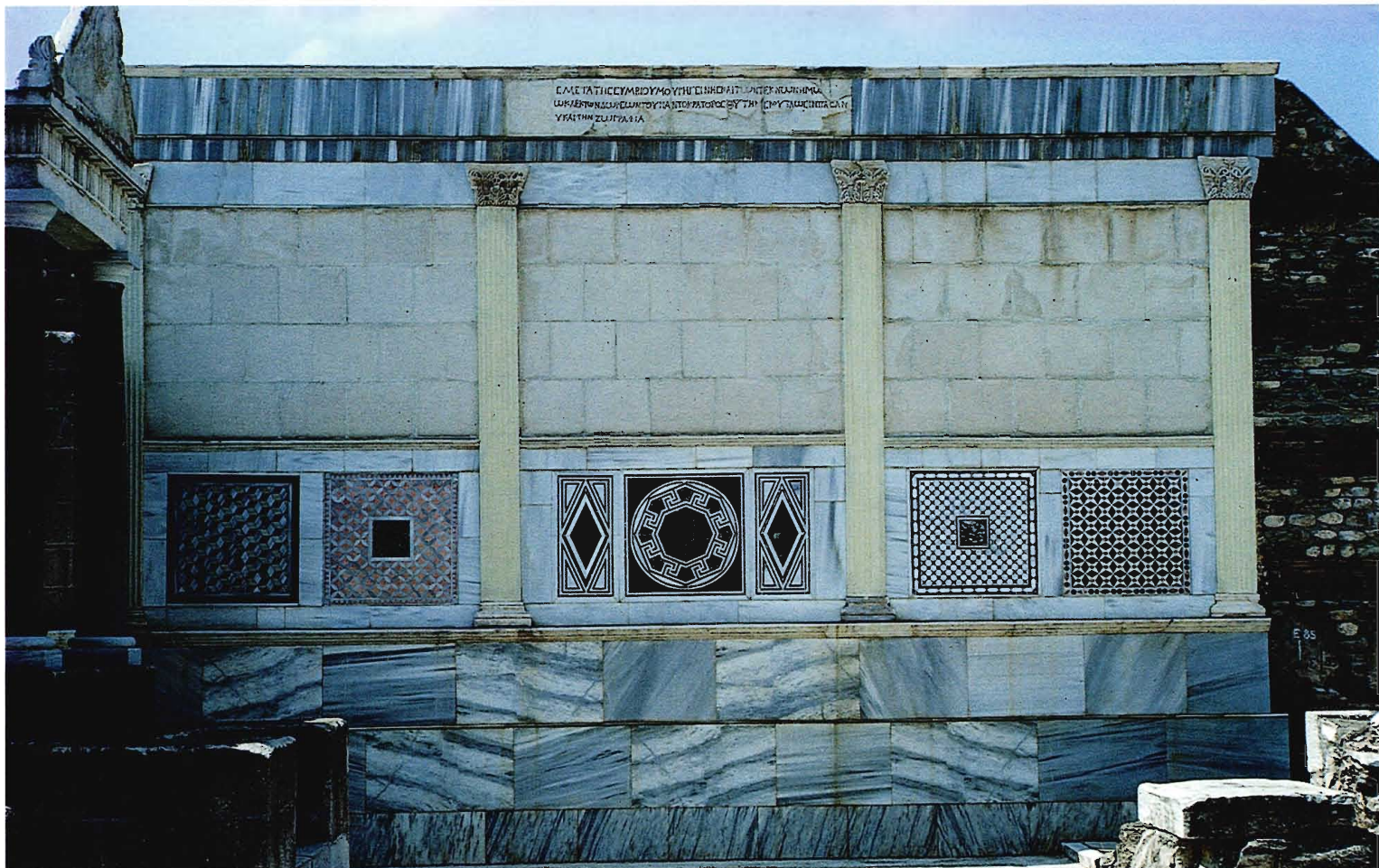
172. Arquitectura de revestimiento -manto dorado, corteccia albertianos - Sinagoga de Sardes. Anastilosis
